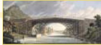
Most na rzece Severn koło Coalbrookdale w Anglii - pierwszy na świecie most wykonany z żelaza
