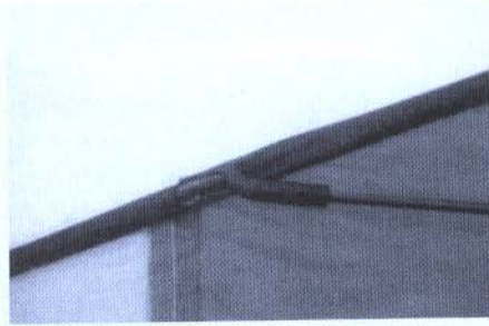
Zakotwiczenie pręta rozpierającego przy pomocy łączówki Jaco
