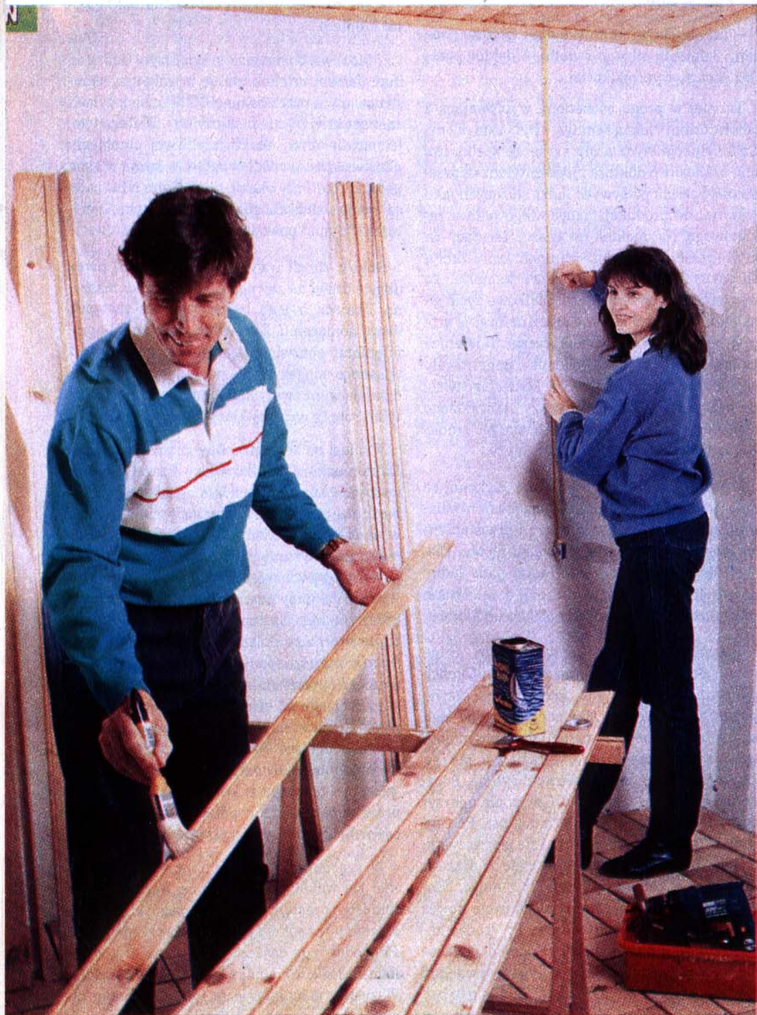
Odpowiednio wyprofilowane drewniane listwy przeznaczone do wykonania wykładziny w pomieszczeniu mieszkalnym muszą być zabezpieczone przed wilgocią, zanieczyszczeniami itp. za pomocą bezbarwnego, wodoodpornego lakieru
