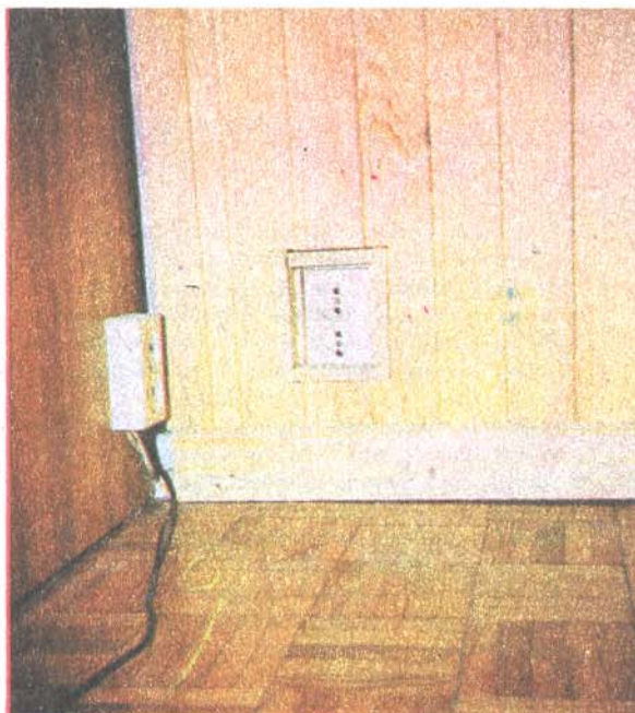
Fot. 4. Wykończenie otworu z gniazdem sieciowym oraz wykończenie boazerii u dołu listwą cokołową
