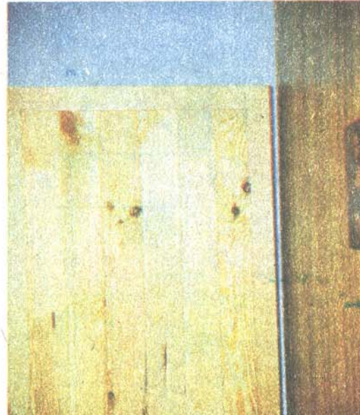
Fot. 2. Sposób wykończenia krawędzi warstwy ocieplającej za pomocą drewnianych kątowników
